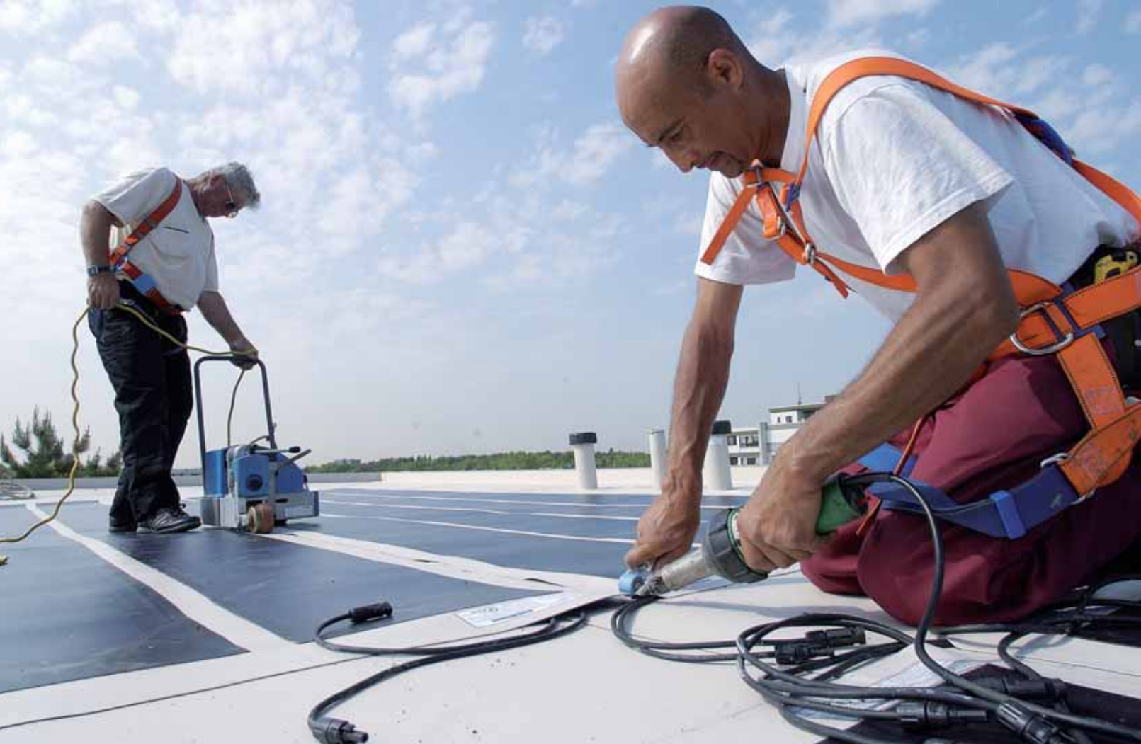
Saldatura degli elementi fotovoltaici
