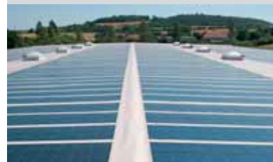
Copertura Soc. Jäger, Fulda
