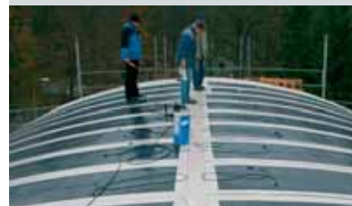
Copertura Wald-Solar-Heim, Eberswalde bei Berlin
